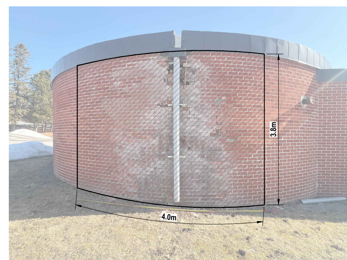
PHOTO #2: DIGESTER #1 WEST ASPECT SCALE: N.T.S.
