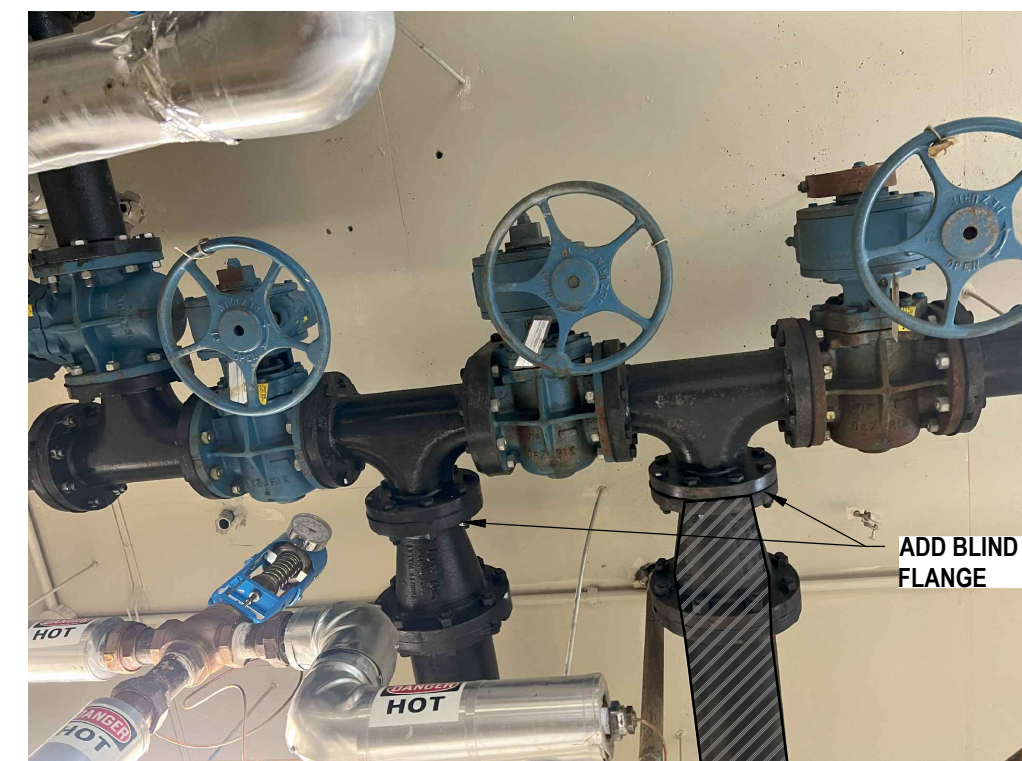
PHOTO No.1 EXISTING DIGESTER HEADER SCALE: N.T.S.
