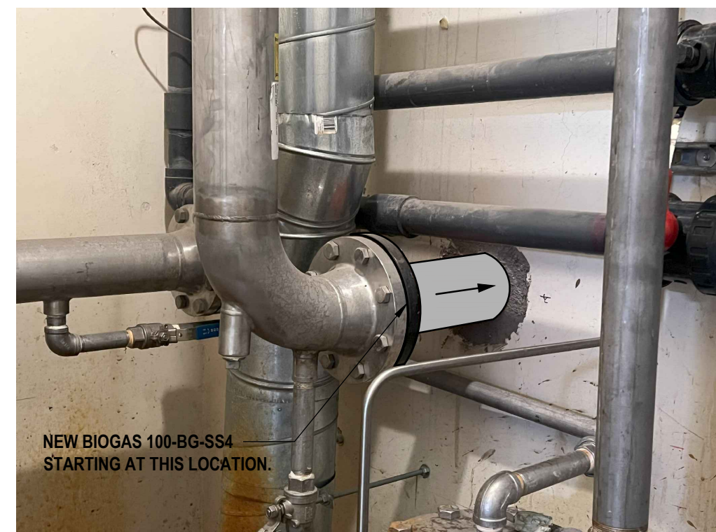
PHOTO No.4 BIOGAS FORCEMAIN SCALE: N.T.S.
