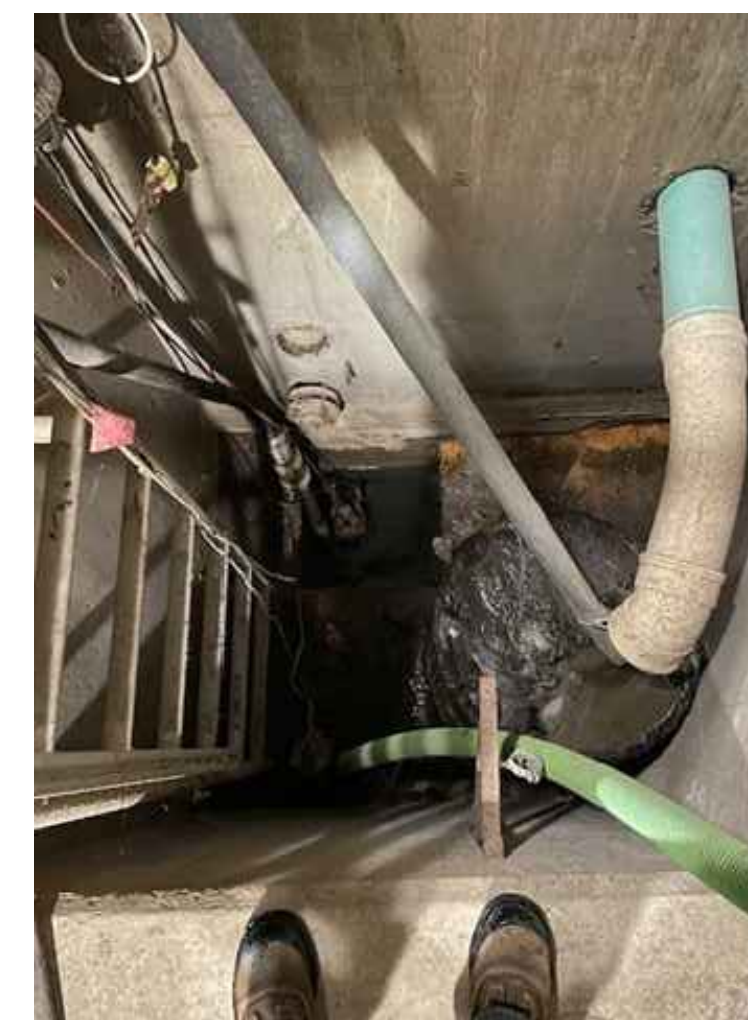
PHOTO #1: EXISTING SUMP PIT SCALE: N.T.S.
