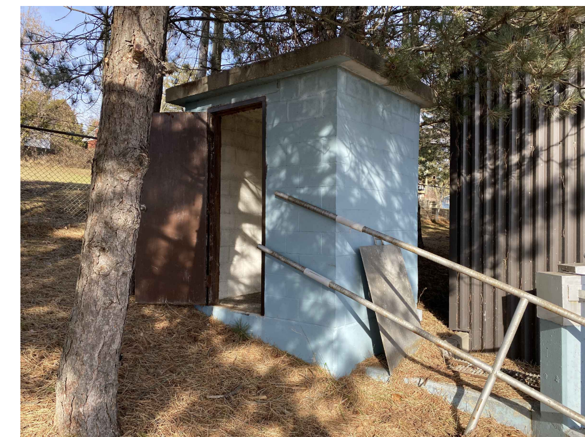
PHOTO # 1 - WEST FACE OF MANHOLE #2 PENTHOUSE SCALE: N.T.S.
