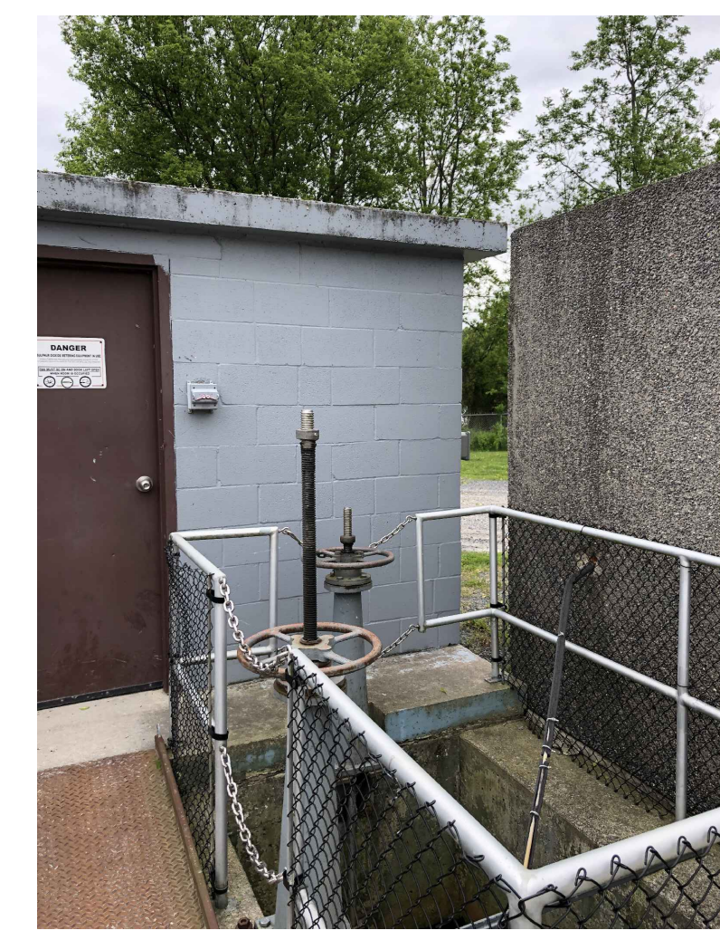
PHOTO #1 - CCT2 INLET CHAMBER SCALE: N.T.S.
